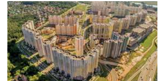
ЖК «Солнцево-парк» Московская обл., пос. Внуковское, д. Пыхтино
